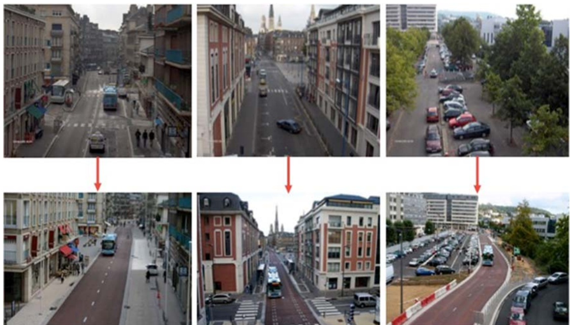
Figura 4-30: Rouen (Francia): prima e dopo l'intervento
