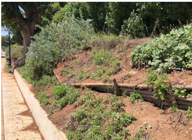
Figura 3.4 – Le immagini sovrastanti mostrano l’inclinazione verso valle delle staccionate e degli alberi, atte ad indicare fenomeni di creep superficiali.
