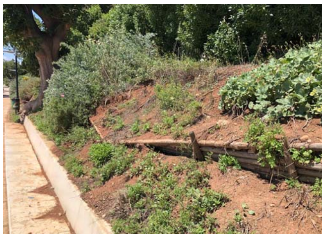
Figura 4.7 – Le immagini sovrastanti mostrano l’inclinazione verso valle delle staccionate e degli alberi, atte ad indicare fenomeni di creep superficiali.
