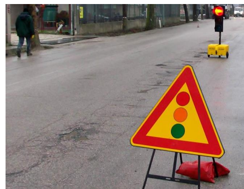
Figura 7 - Inserimento semaforo di cantiere
