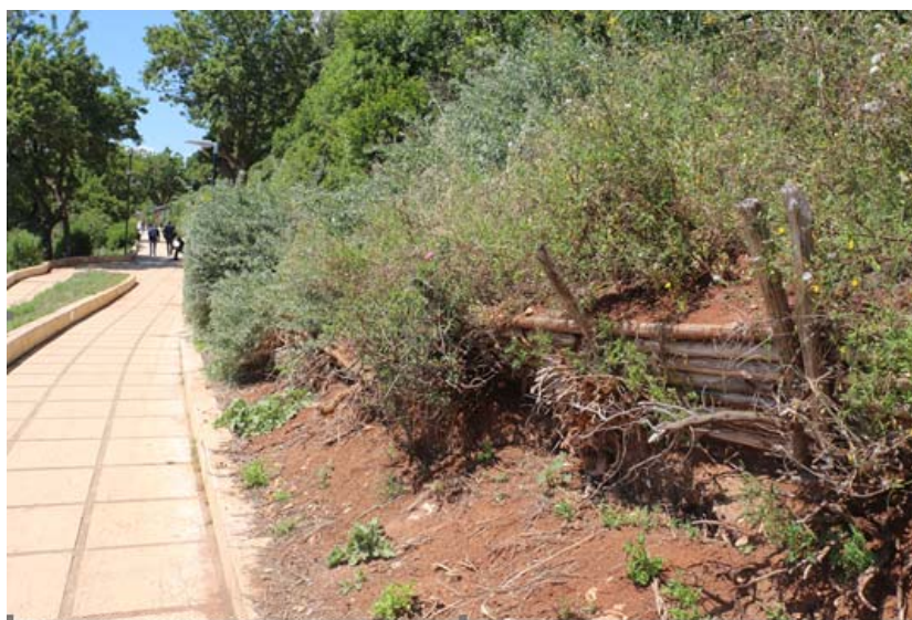
Figura 2.5 – Lo scivolamento dei materiali ha interessato la strada interna al lungomare provocando smottamenti di piccole dimensioni
