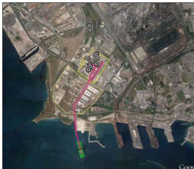
Sorgenti emissive dello stabilimento ENI. Fonte: Rapporto di valutazione del Danno Sanitario nell'area di Taranto, 2015
