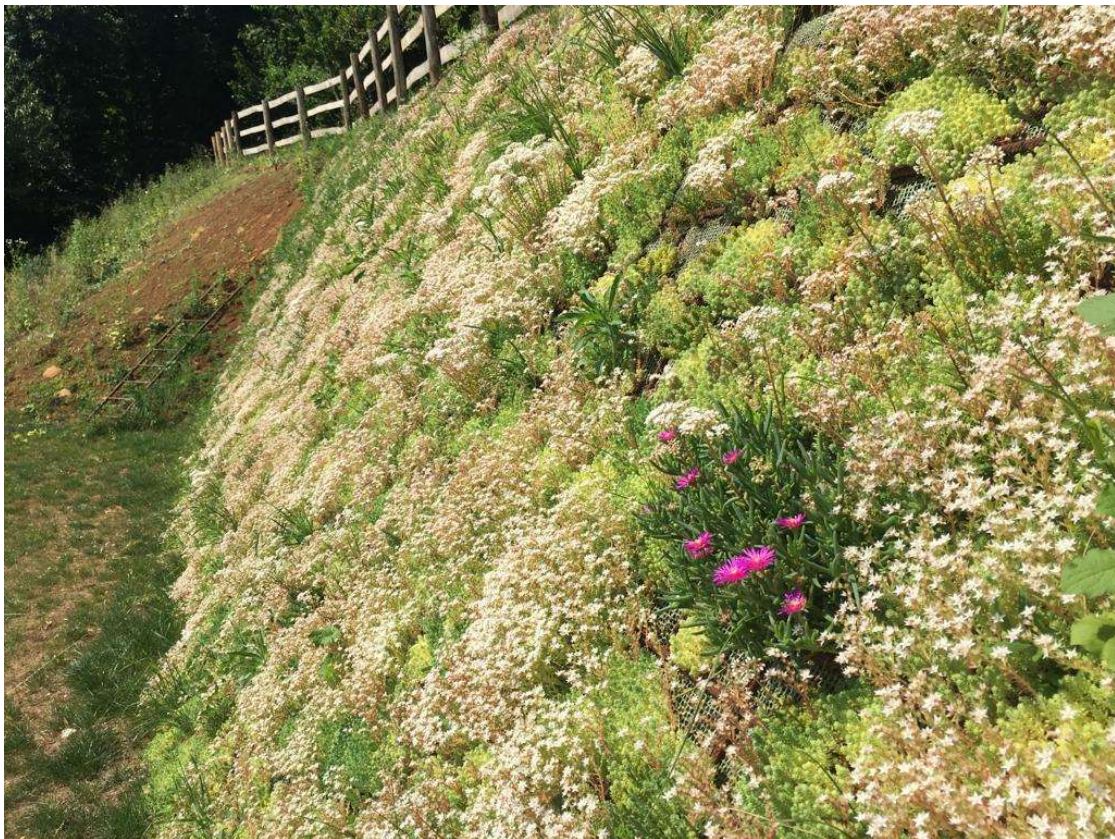
Figura 2.3 Effetto sulla scarpata della semina con Sedum.
