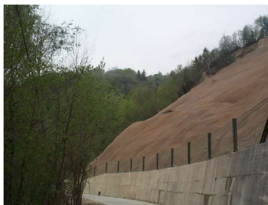
Figura 2.1 Esempio di scarpata oggetto di rivestimento antierosivo con biorete Bionet HC70. Prima della posa e a posa appena terminata.
